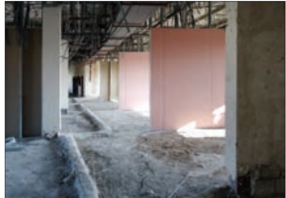
پیشرفت عملیات نازک کاری ساختمان فن بازار، مورخه: ۹۳/۰۸/۰۷
